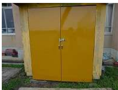
校舎外倉庫の扉修繕
