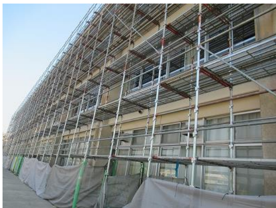
エアコン設置工事を進めていただいています。
